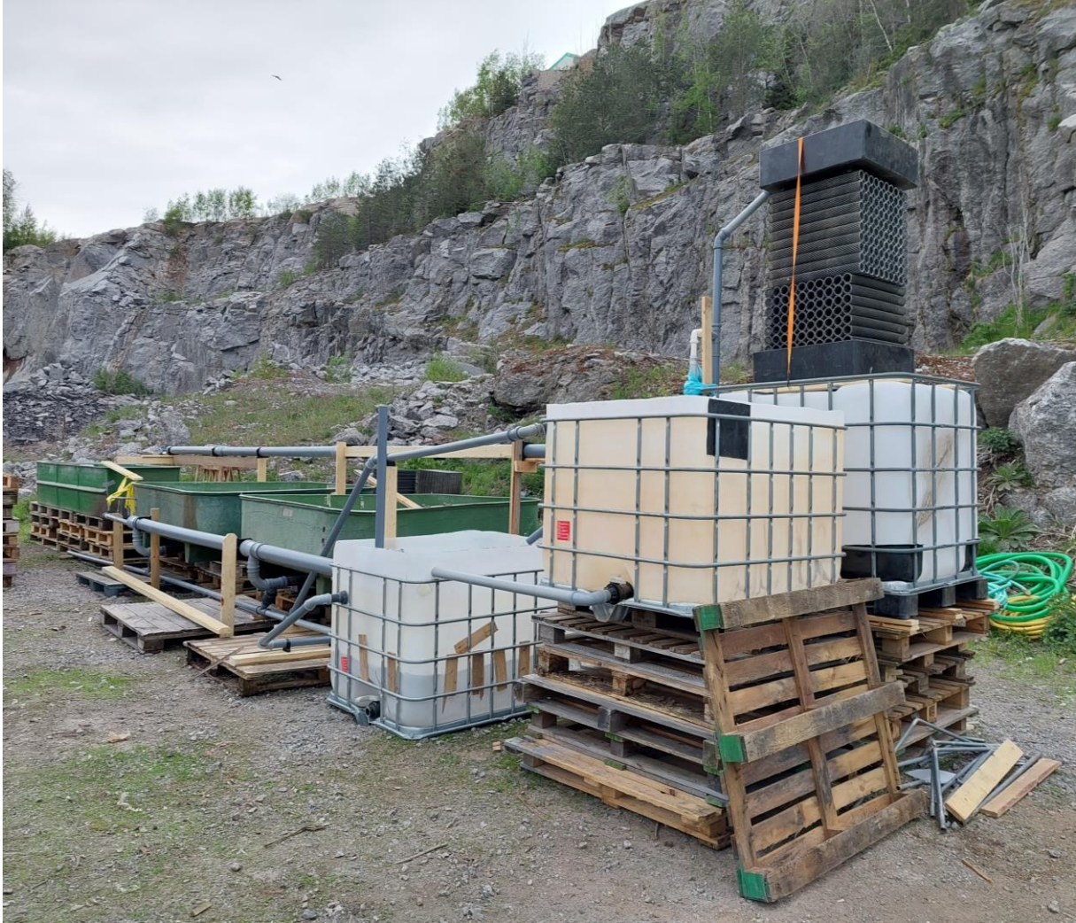
Figur 10. Odlingsanläggningen under uppbyggnad, innan tälten kommit på plats. Luftningstornet av bioblock i brunsvattentanken (längst fram mot kameran) saknas ännu.
